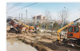
DH1100/1600-L型水平定向钻机内蒙古施工现场
