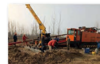
DH5000-LL型水平定向钻机湖北施工现场
