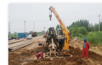
DH500-LL型水平定向钻机山东施工现场
